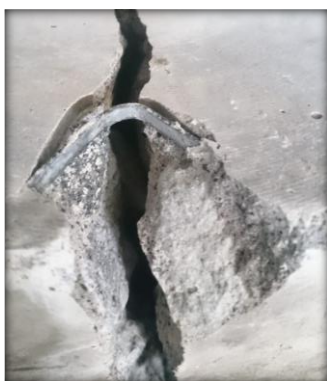
Gambar 19. Serat baja di sela retakan beton
