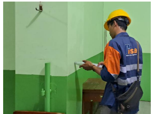
Gambar 6. Dokumentasi uji palu beton Sumber: Dokumentasi pengujian di lapangan, 2023
