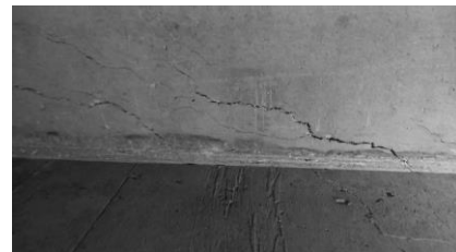
Gambar 16. Kondisi balok yang berdekatan dengan lokasi uji 5 Sumber: Hasil observasi lapangan, 2023
