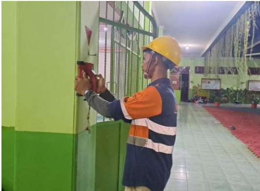
Gambar 8. Pemindaian tulangan Sumber: Dokumentasi pengujian di lapangan, 2023
