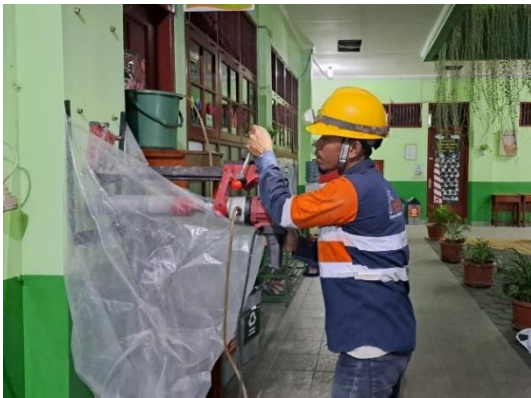
Gambar 9. Pengambilan sampel beton inti Sumber: Dokumentasi pengujian di lapangan, 2023
