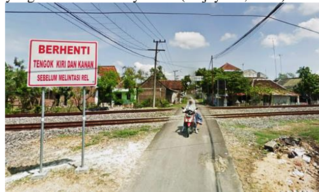
Gambar 7: Perlintasan Sebidang Tidak Terjaga di Kampungbaru, Bojonegoro
