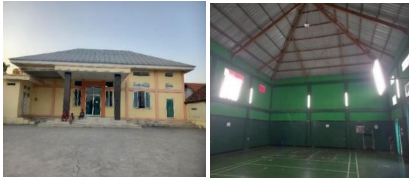
Sumber: Gedung Serbaguna Dusun Banjarpoh Desa Banjarbendo 2024
